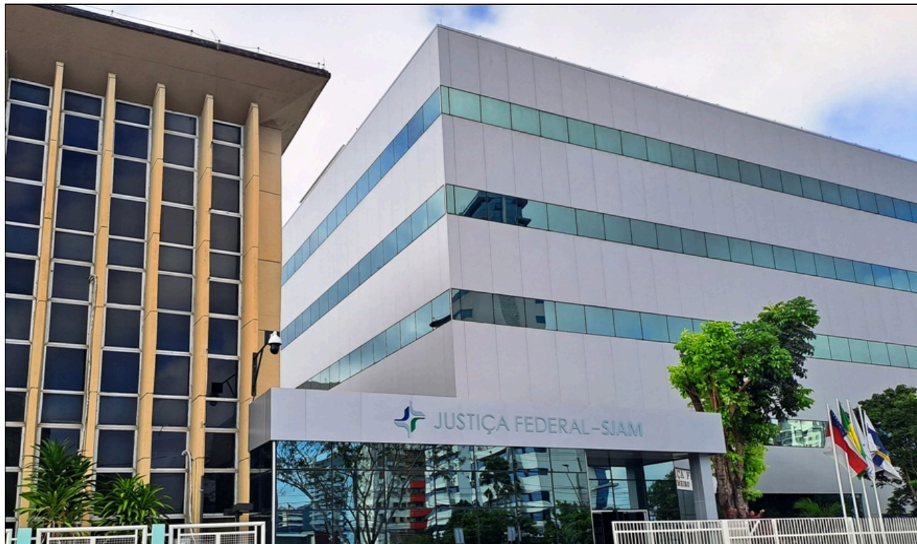
Descrição da Imagem: fachada da Seção Judiciária do Amazonas, mostrando à esquerda o Edifício Rio Solimões, em tonalidade creme e com esquadrias na cor escura, e à direita o Edifício Rio Negro, em tonalidade branca com esquadrias espelhadas de cor esverdeada. Ao canto direito, as bandeiras do Estado do Amazonas, da República
